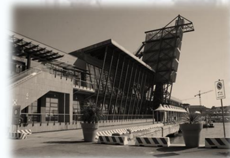
VENEZIA – STAZIONE MARITTIMA – - FABBRICATO 103 – PRIMO PIANO AUDITORIUM
